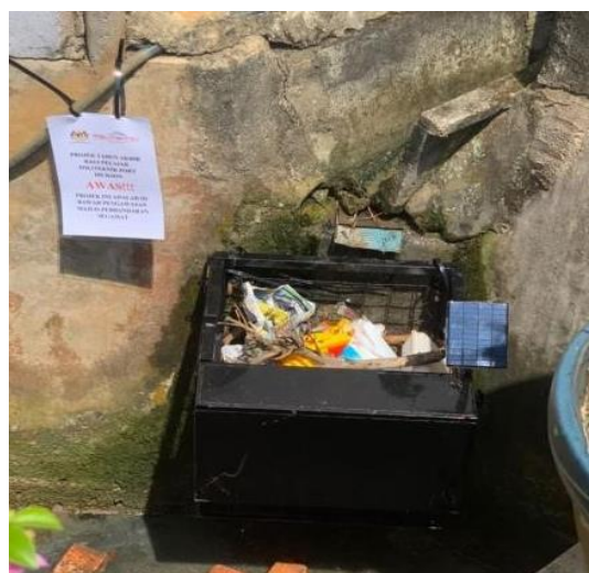
Rajah 8: Pemasangan GTEF di dalam sistem saliran.
