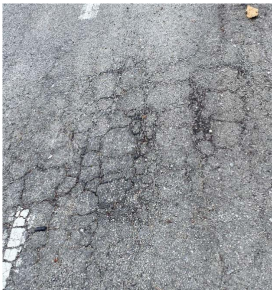
Rajah 7 Retak Blok
