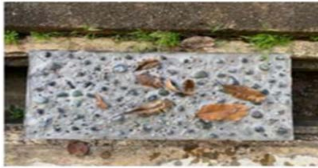
Rajah 4: Penutup Longkang Mesra Alam Dapat Menghalang Sampah Dari Memasuki Longkang
